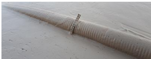
Betonnagels i.p.v. pluggen:
